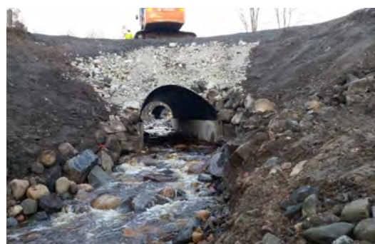
● ● ● Figur 9 Branddammen efter åtgärd
