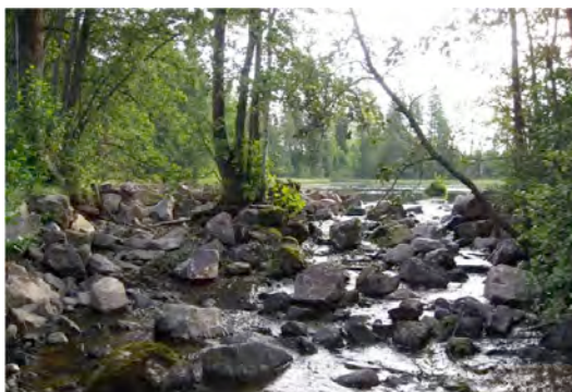
Figur 37 Dammen vid Berget efter åtgärd.
