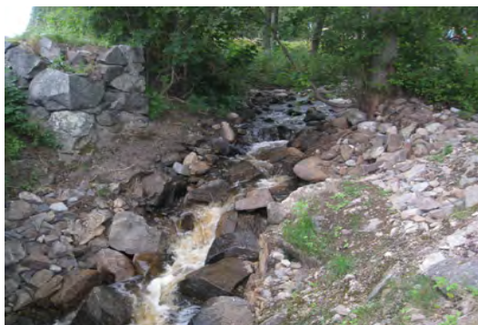
● ● ● Figur 42 Dammen uppströms väg 575 efter åtgärd
