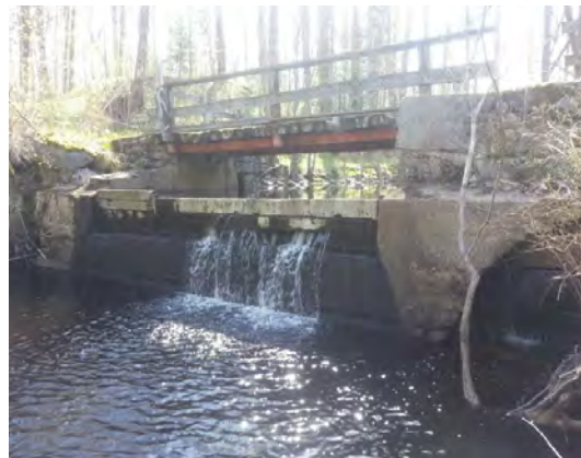
Figur 12 Herrgårdsdammen före åtgärd
