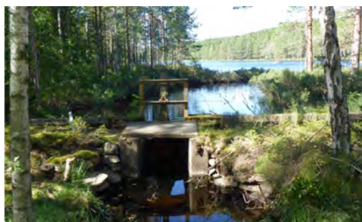
● ● ● Figur 28 Dammen vid Acksjön före åtgärd.
