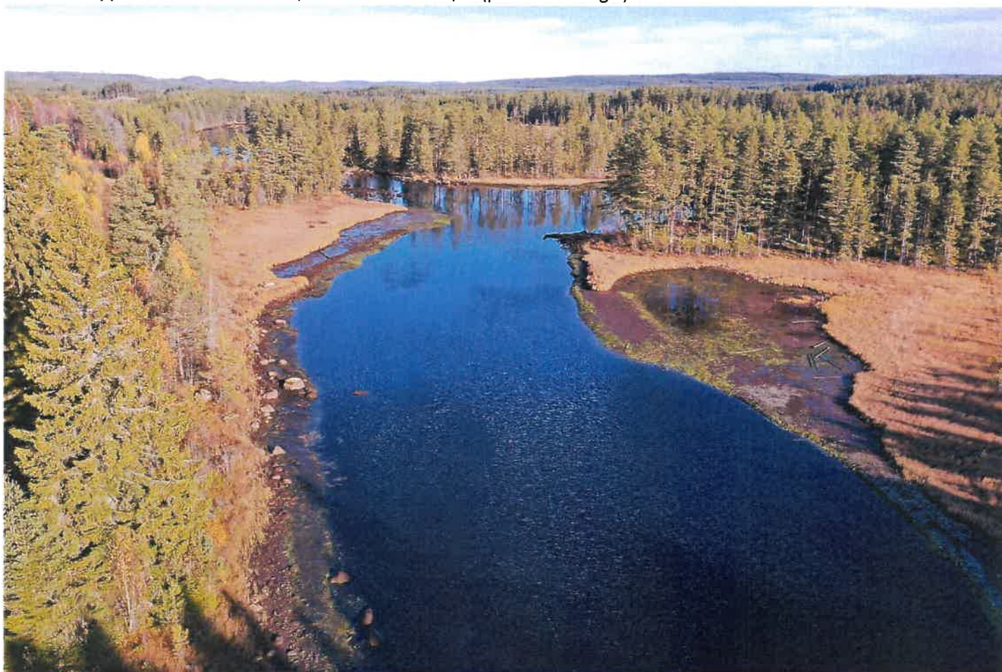
Uvån strax uppströms Sikforsdammen, vattennivå ca +184,03 (provavsänkning 2)
