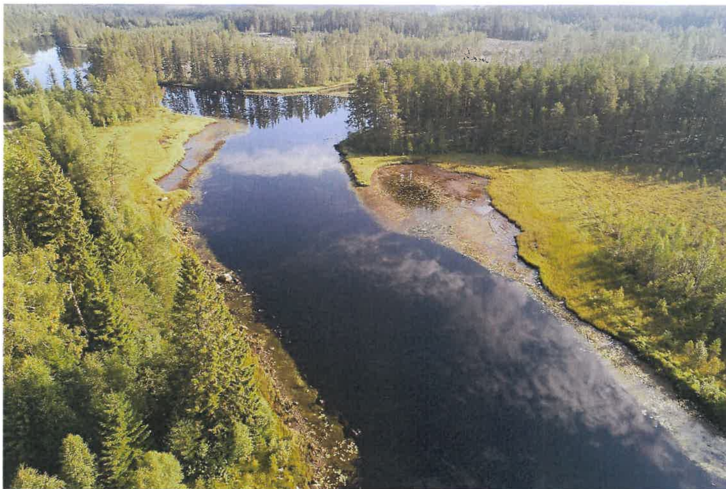
Uvån strax uppströms Sikforsdammen, vattennivå ca +184,30 (provavsänkning 1)
